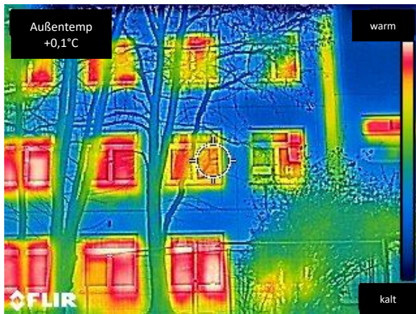
Haus 3-N: Fenster schlechter als Wand
